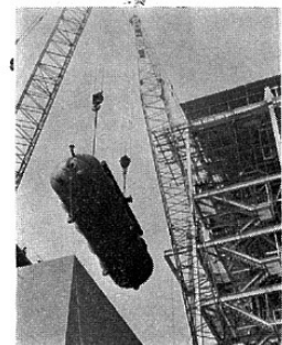
吊り上げられる脱気器
