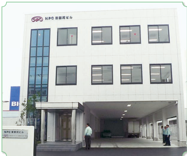
▲完成したNPC東那珂ビル
