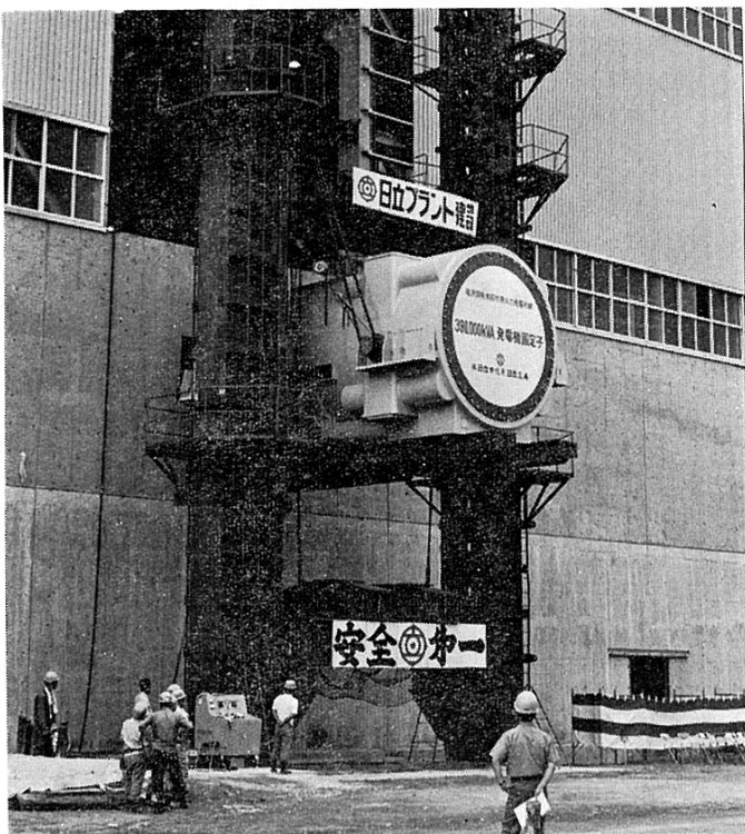
関係者の見守るなかで、吊揚げられるステーター
