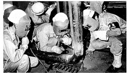
△配管組立訓練
