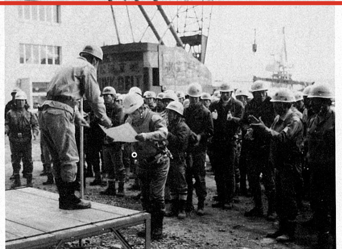
朝礼時に安全表彰を受ける速水松島建設所長
