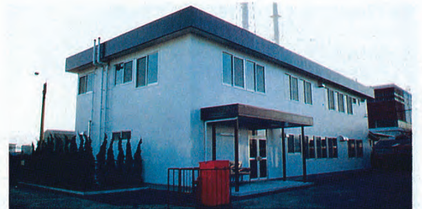
△竣工した唐津事業所協力会社控所
