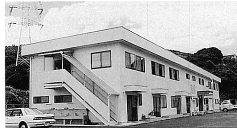
△竣工した松浦事業所新社屋 同発電所の保守業務に従事していくこととなります。
