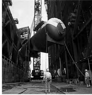
中国電力三隅発電所建設工事での給水加熱器の吊り上げ(工期:1995~1998年)
