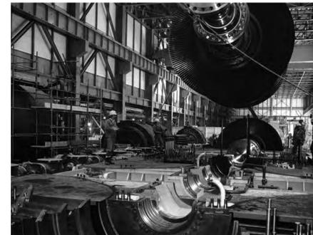
九州電力川内原子力発電所2号機建設工事での低圧タービンローター底込み(工期:1978～1985年)
